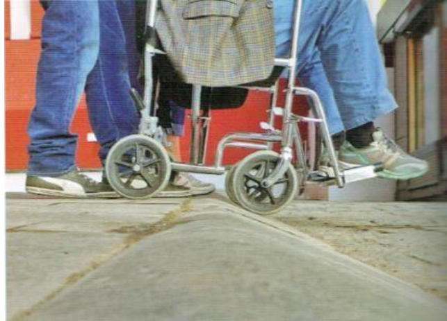
Bordillos demasiado inclinados
